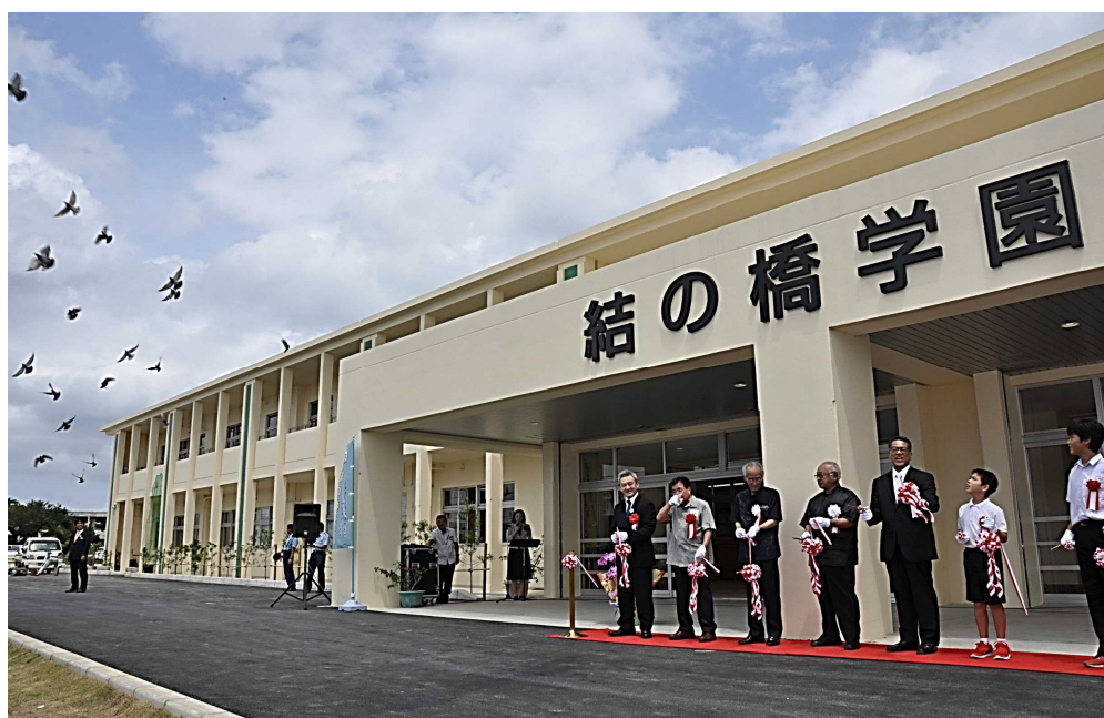
宮古島市立小中一貫教育校 伊良部島小学校・伊良部島中学校 愛称「結の橋学園」
